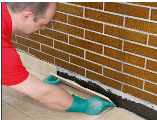
20 ... en het zetten van de plint.
