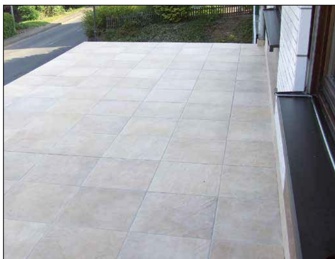
24 De nieuwe tegelafwerking op een balkon met de Sopro systeem componenten.
