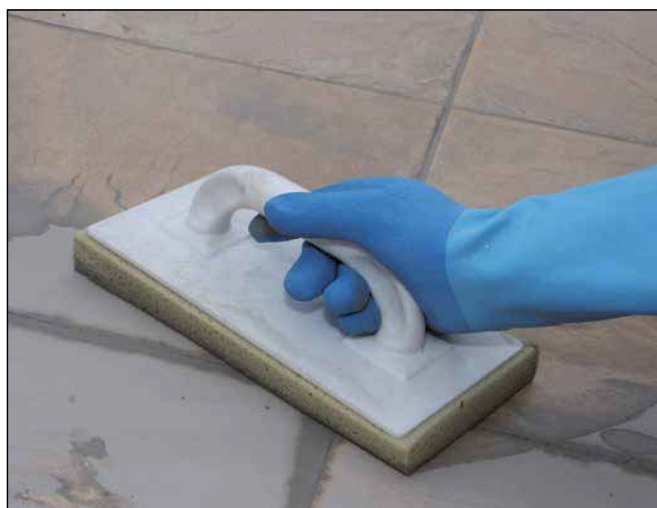
22 Het afwassen van de tegelafwerking na voldoende standtijd van de ingevoegde Sopro voegenmassa.
