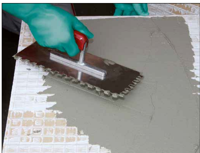
17 De toepassing van de Buttering-Floating methode is van het formaat en de geschiktheid van de achterzijde van de tegel afhankelijk en dient voor een verregaande volvlakkige verlijming van het afwerkingsmateriaal.
