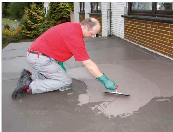
14 Het aanbrengen van de 2. laag op de reeds na 2 uur doorgedroogde 1. afdichtlaag.
