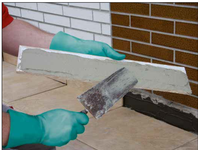
19 Aanbrengen van een Sopro Flexlijm (bijv. Sopro's No.1, Sopro FKM® XL) op de achterzijde van de op maat gesneden plint.
