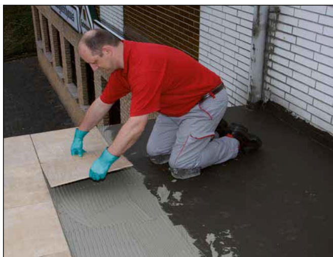
18 Het inleggen en aanschuiven van de platen in het verse lijmbed.
