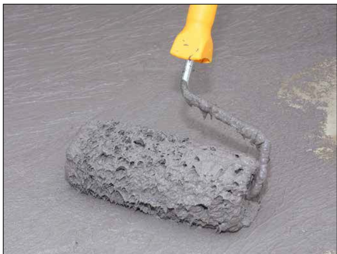
13 De verwerking van de Sopro TurboDichtlaag 2-K kan ook met een lamsvelroller uitgevoerd worden.
