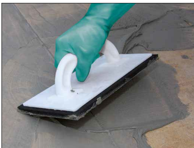
21 Invoegen van een Sopro Voegmassa (bijv. Sopro DF 10® Designvoeg Flex of Sopro Flexvoeg FL) na uitharding van de Sopro Flexlijm.
