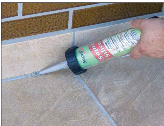
23 Aanbrengen van de Sopro Sanitair Siliconen in de aansluit- en bewegingsvoegen.
